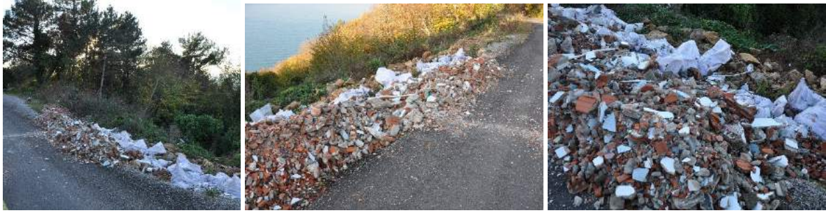
Şekil 9. Eğimli yamaçtan aşağıya doğru dökülmüş inşaat atıkları.
