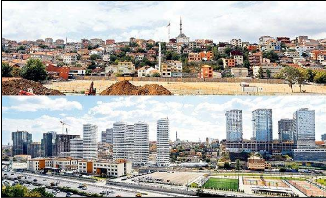
Şekil 4. Fikirtepe; kentsel dönüşüm öncesi ve sonrası.
