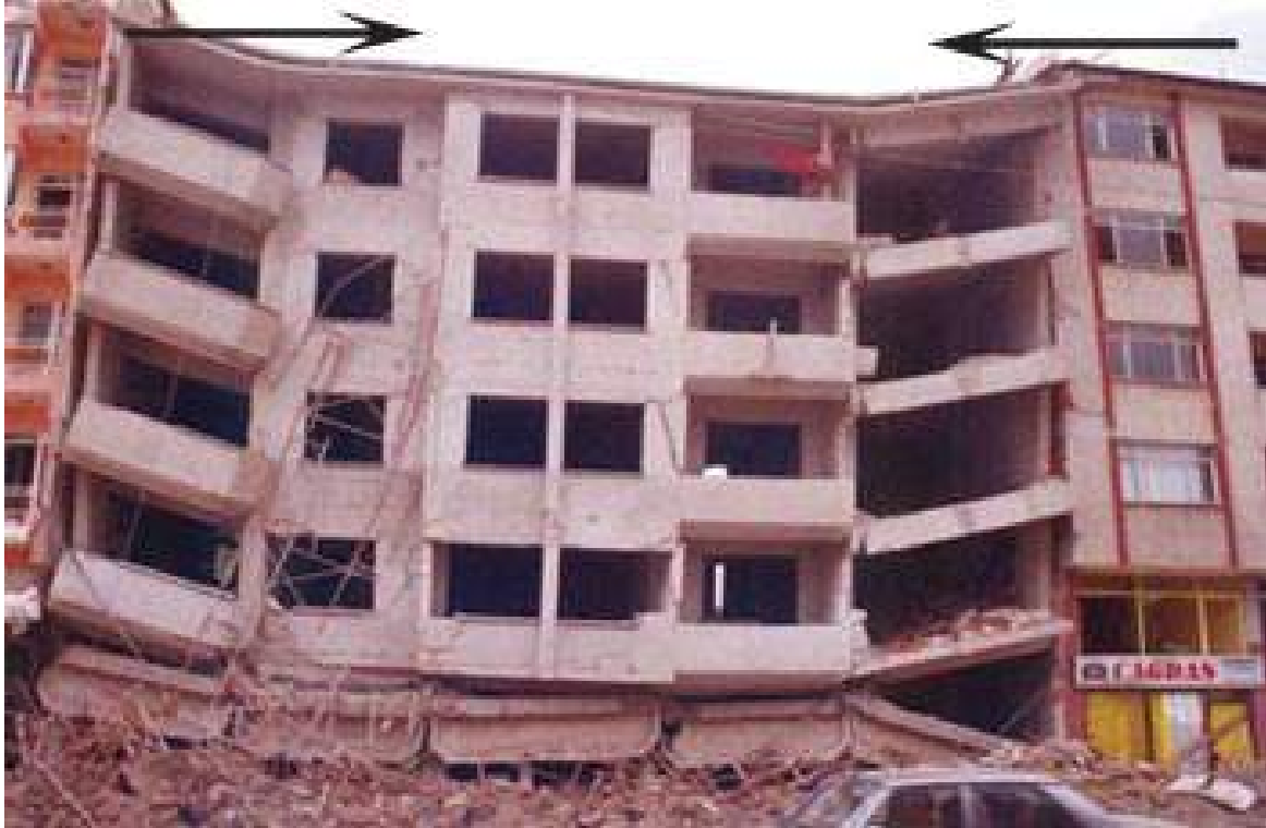
Şekil 7. Bitişik Nizam Teşkil Edilmiş Yapıların Çarpışması Dolayısıyla Oluşan Hasar
