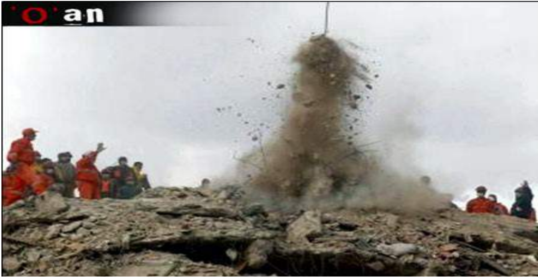
Şekil 9. Kalitesiz Malzeme Dolayısıyla Çöken Zümrüt Apartmanı (Türkiye, 2004, M:0.0)
