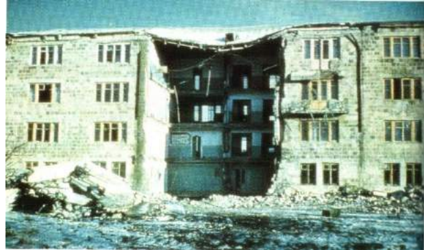
Şekil 4. TDY'ne göre A2 Türü Döşeme Süreksizlikleri ve USSR Academy Binası (Ermenistan, 1988, M:6.9)
